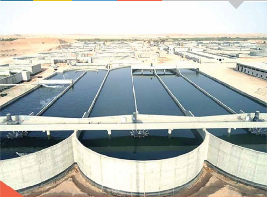
محطة الصرف الصحي بأكتوبر الجديدة
